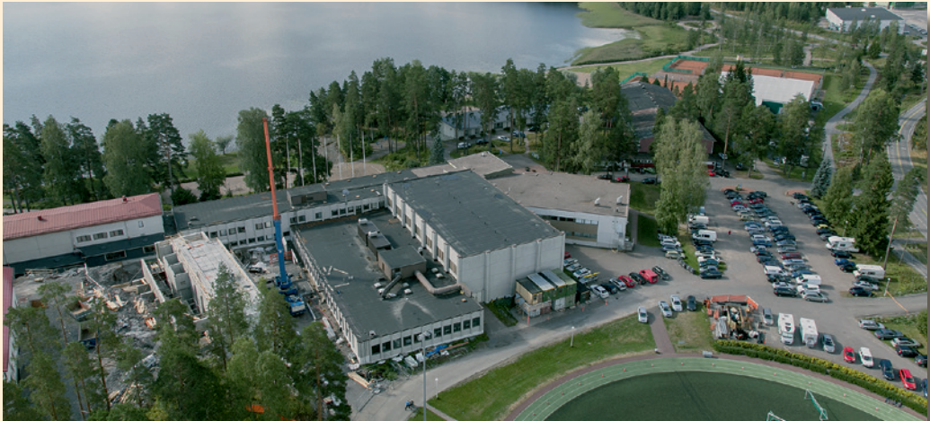
Kalliopajun oppilasasuntola nivoutuu hyvin Liikuntakeskus Pajulahden päärakennuksen yhteyteen. Kuva on otettu elokuussa 2014, jolloin asuntolan peruskivi oli jo muurattu.
