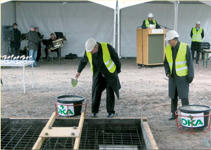
Urheiluopistosäätiön luottamushenkilöt osallistuivat runsaslukuisesti Pajulahti-hallin peruskiven muuraustilaisuuteen lokakuussa 2009. Muurauksen aloittivat säätiön valtuuskunnan puheenjohtaja Paavo Lipponen ja Lemminkäinen Talo Oy:n toimitusjohtaja Juha Nurmi .
